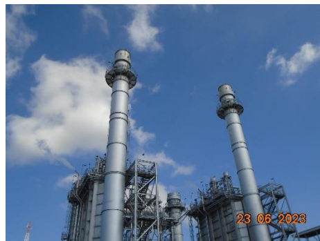
ภาพที่ 2-2 ปล่อง HRSG 11 และ HRSG 12
